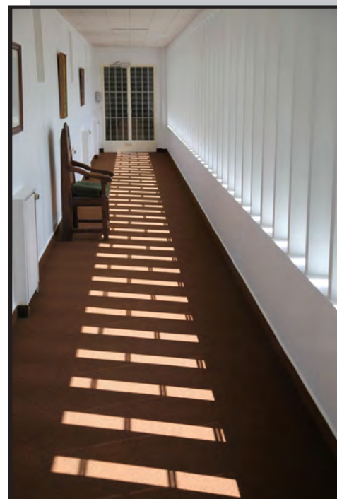
Couloir reliant l'hôtel du Préfet aux bâtiments administratifs
