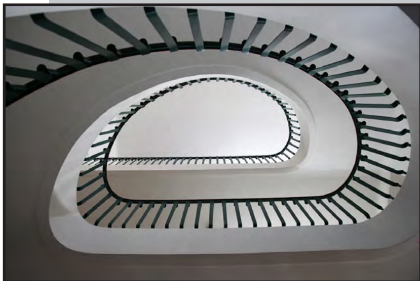
Escalier desservant la chambre dite du ministre
